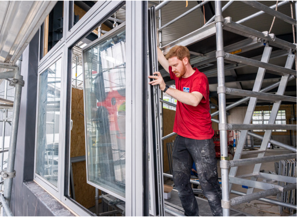
Angepasst, gereinigt und selbst verbaut: Die Keller Metallbau AG nutzte ihre Fachkompetenz für den Einbau der wiederverwendeten Bauteile.
