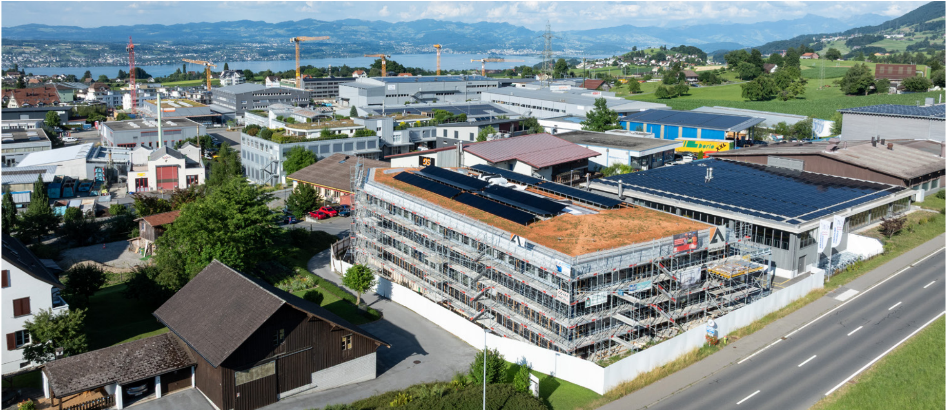
Noch eingerüstet, aber bald bezugsbereit: Bis Ende August werden die Keller Metallbau AG und die Wädi Bleche GmbH ihren neuen Firmensitz in Samstagen beziehen.
